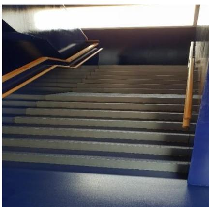
**ESC-1:** Escalera interior abierta no protegida situada en ala izquierda del edificio que ofrece un ancho de paso más desfavorable de 1,78m y que ofrece una evacuación descendente desde la 2ª planta hasta la planta baja, donde se produce la salida a calle.
