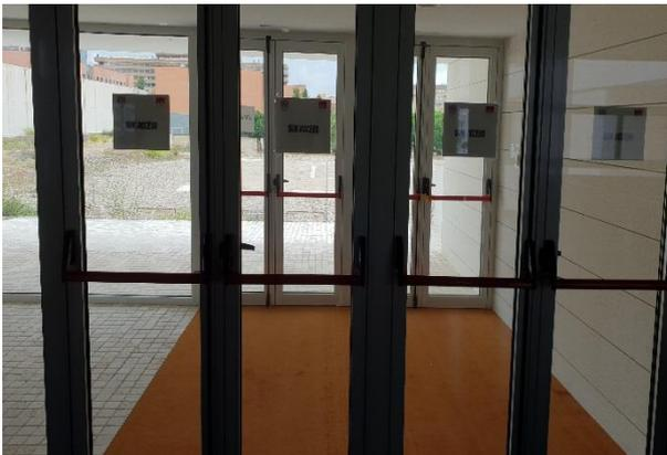
**SE8:** Salida de emergencia, ubicada en la primera planta, y actualmente **cerrada y bloqueada** hasta realización de trabajos de urbanización en el exterior. No se han podido tomar las medidas de paso al encontrarse inaccesible su apertura. Realizada sobre estructura metálica y acristalada de doble cuerpo con cuatro puertas dotadas de barras antipánico en todas ellas.
