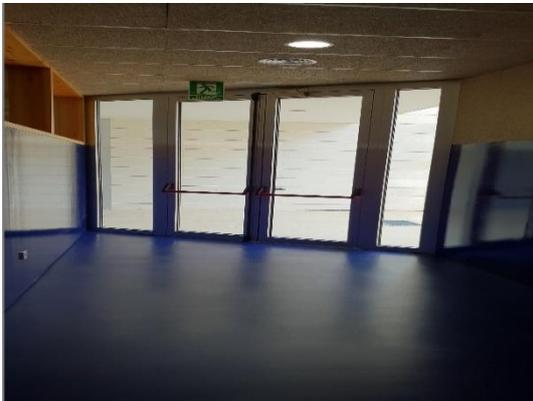
**SE2:** Salida de emergencia, realizada sobre estructura metálica y acristalada, compuesta por dos hojas fijas y dos puertas dotadas de barras antipánico con una capacidad de paso de 1, 60 m. Dispone, también, de un sistema de retención magnético.
