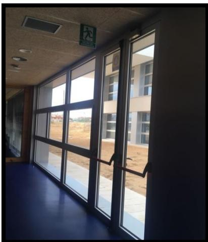
**SE4:** Salida de emergencia de doble hoja acristalada sobre estructura metálica que ofrece un ancho de paso de 1,21m..
