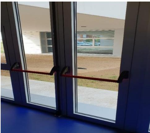
**SE6:** Salida de emergencia, realizada sobre estructura metálica y acristalada, compuesta por dos hojas dotadas de barras antipánico con una capacidad de paso de 1,21 m.
