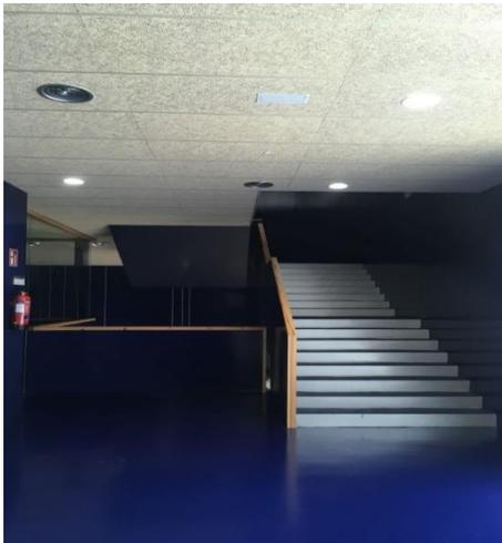
**ESC-3:** Escalera interior no protegida que se sitúa en el lateral derecho de la edificación y que comunica la segunda planta con la primera planta con la planta cubierta de una evacuación descendente. Ofrece un ancho de paso más desfavorable de 1,96m. Igualmente los escalones presentan una huella de 30 cm y una contrahuella de 17cm.
