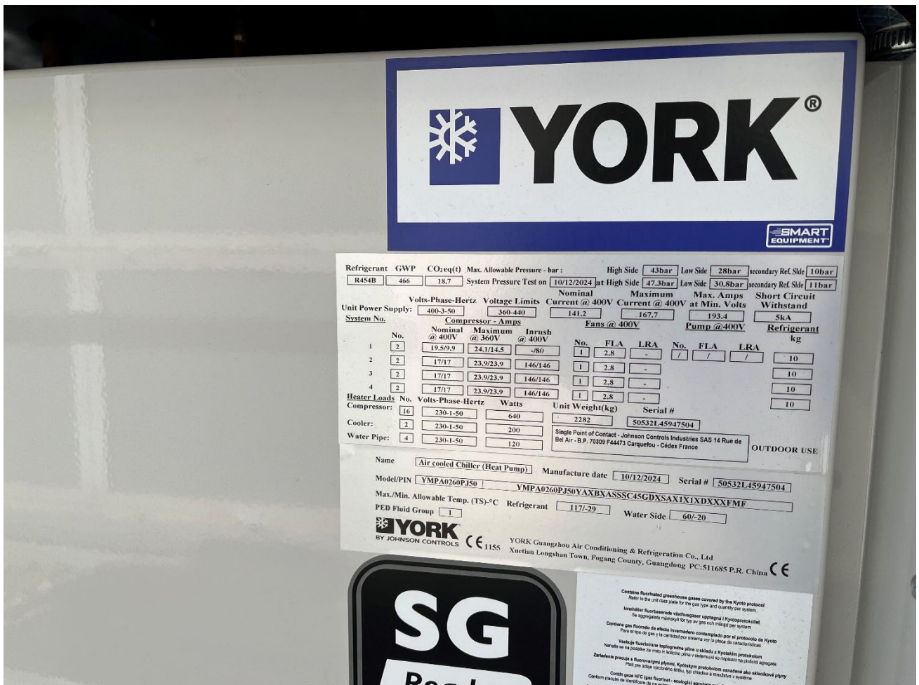
Ilustración 6: Placa de características de las máquinas instaladas
