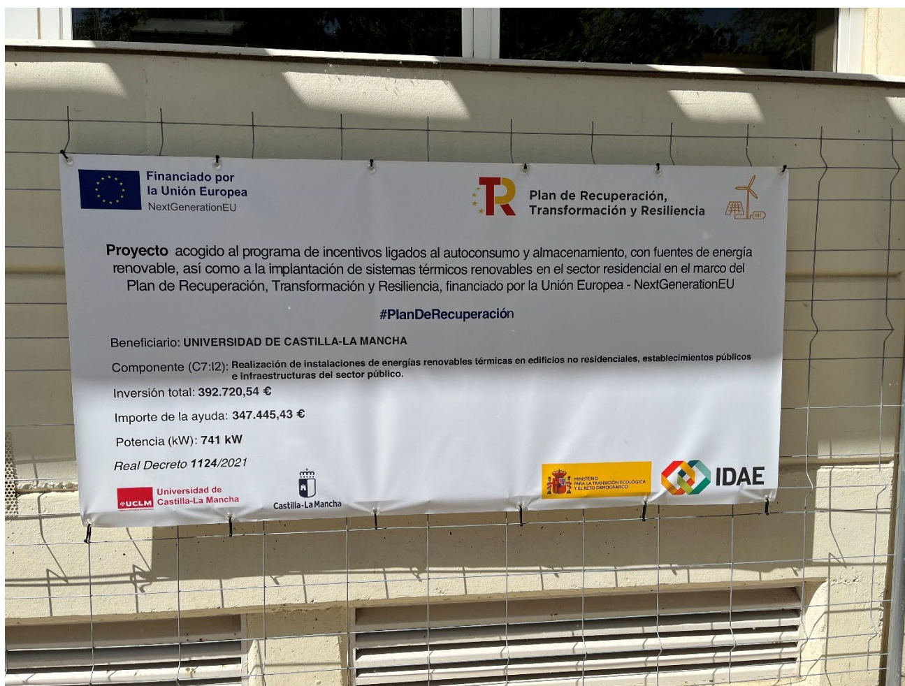
Ilustración 9: Cartel de obra dispuesto en la fachada del edificio
