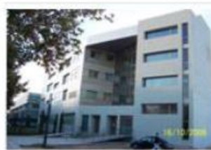
EDIFICIO MARIE CURIE
